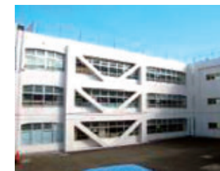
▲耐震化された校舎
